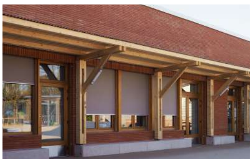
Nouvelle isolation thermique extérieure, avec une vêtue en brique pleine à la fois esthétique et performante
