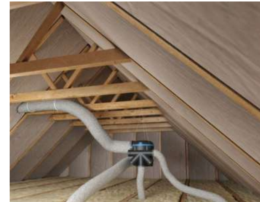
PRINCIPE DE LA VMC SIMPLE FLUX HYGRORÉGLABLE
