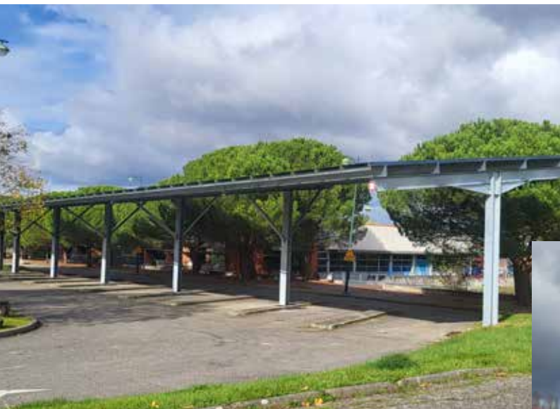
Ombrières du parking du collège Claude-Cornac
