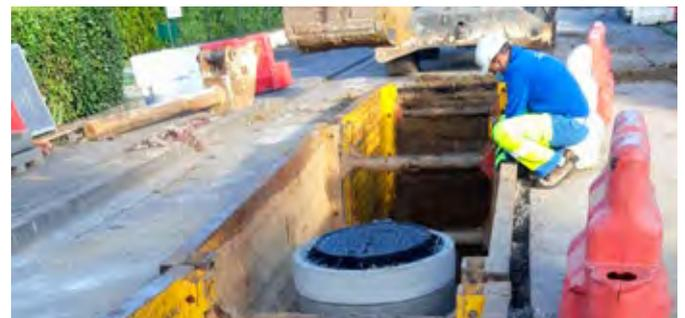
La rue du Barry a été perturbée par la réfection du réseau d'eau potable ainsi que par la mise en étanchéité du réseau d'assainissement par un système de manchonnage en évitant ainsi des terrassements trop importants, bien que par endroits des réfections totales ont dû être réalisées. De plus, une remise en état du réseau pluvial a été fait dans la même opération.
